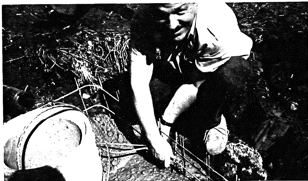
Fiorenzo alle prese con la doppia messa a terra (1cm treccia rame).
