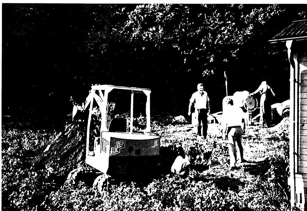
Gli scavi per il traliccio da 15m proseguono
