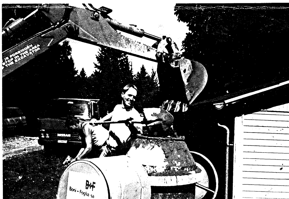
Franco litiga con la pala e alle spalle Tino continua a svuotar cemento.
