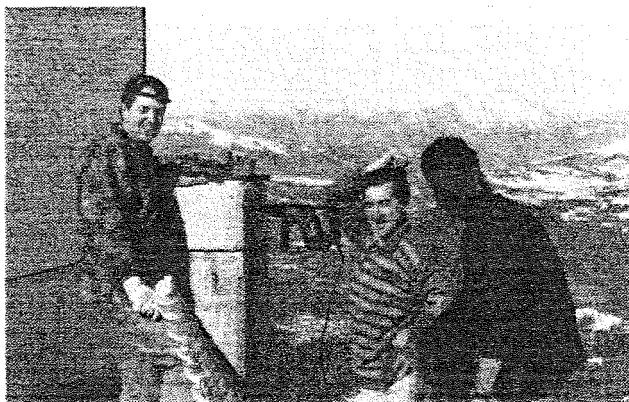
ALCUNI PARTECIPANTI AI LAVORI D'INSTALLAZIONE ANTENNE E IL FAVOLOSO ORIZZONTE DAI 1700MSM DEL MONTE LEMA
