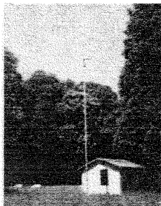
IMPIANTO ANTENNE IN SEDE
